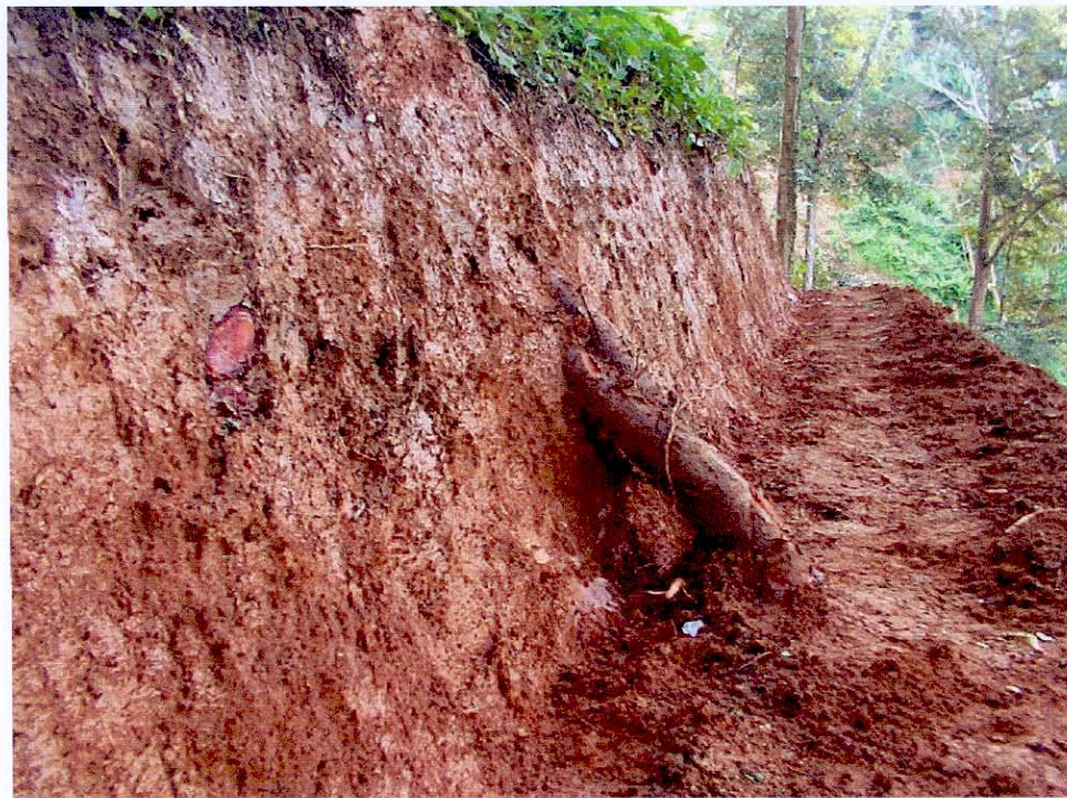
รูปที่ 25 แสดงการสร้างชั้นบันไดดินบนพื้นที่ลาดชัน
