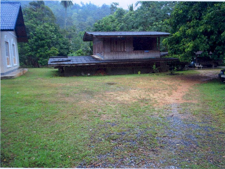
รูปที่ 6 สภาพปัจจุบันพื้นที่ที่เคยถูกตะกอนทรายทับถมจากดินถล่ม อ.พิปูน
