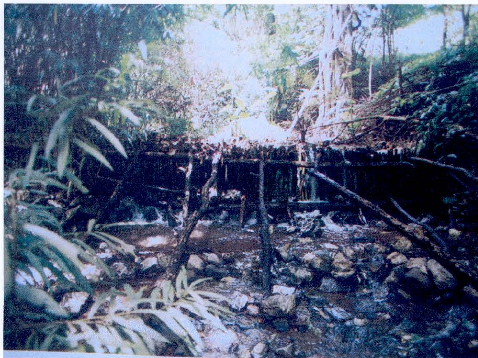
รูปที่ 29 ฝายชะลอความชุ่มชื้น (Check Dam)
