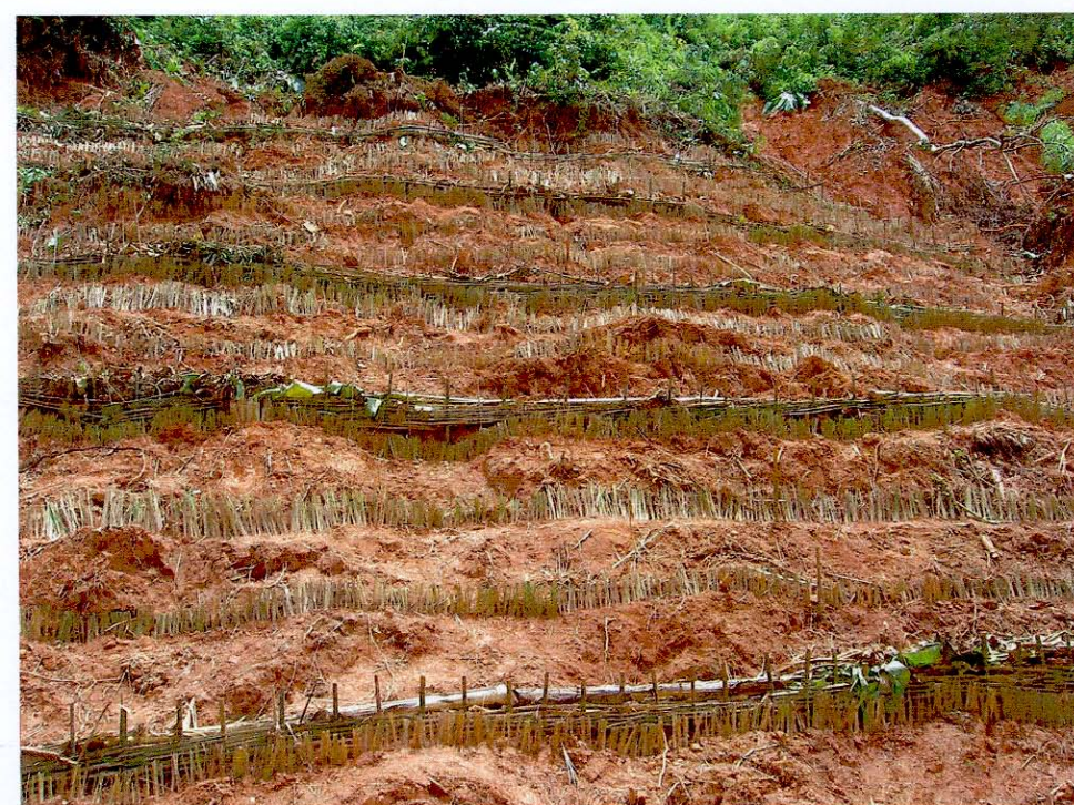
รูปที่ 27 แสดงการปลูกหญ้าแฝกบนพื้นที่ลาดชันบนไหล่ถนน
